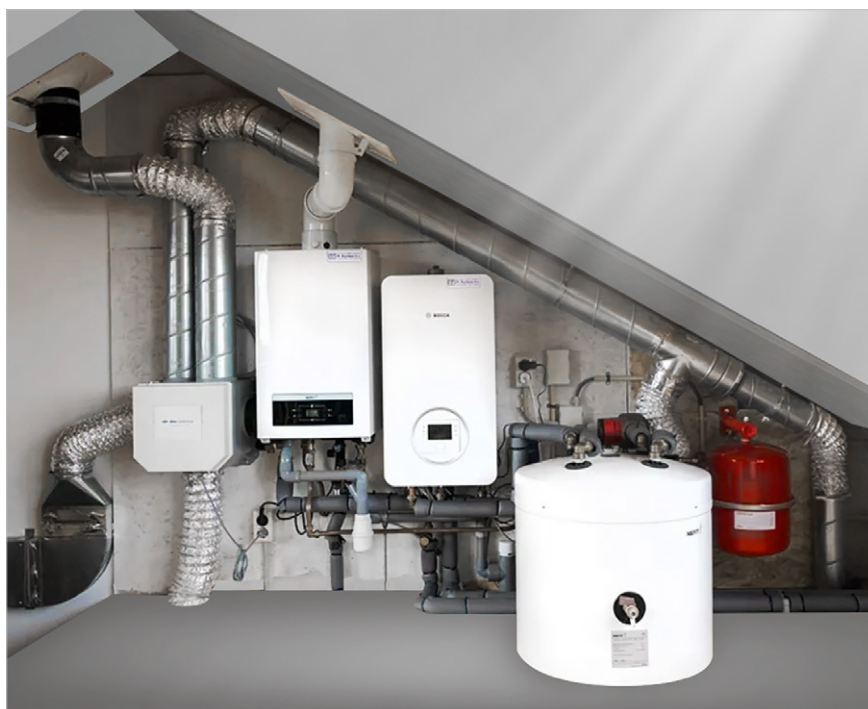
▶ Figuur 1: Nefit Bosch hybride opstelling met buffervat
